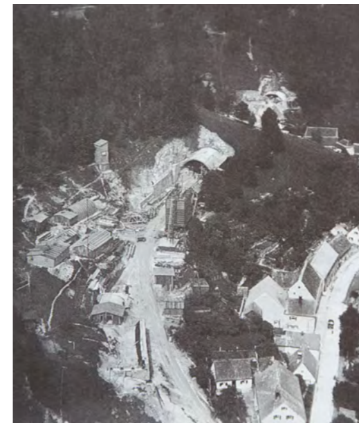
Bau des Tunnels, Mitte 1950er Jahre
